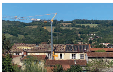
Réfection du toit de l'EHPAD
