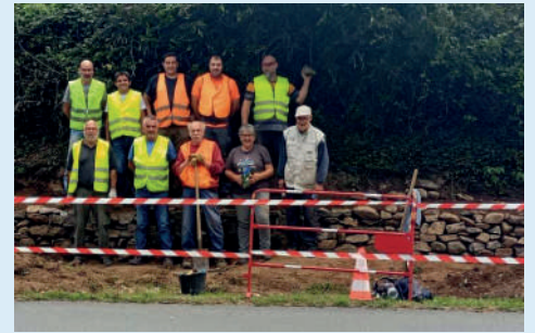
Construction d'un mur en pierres sèches
