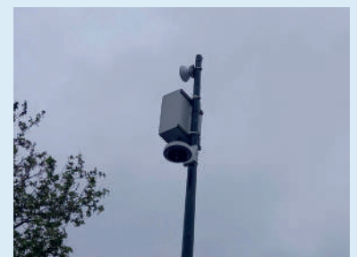
Mise en place de caméras
