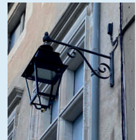
Mise en place des éclairages LED
