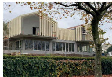
Travaux de l'EHPAD
