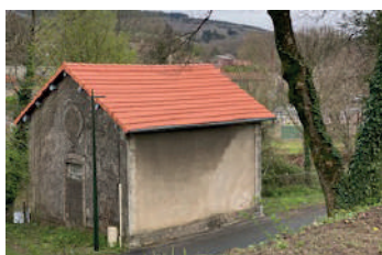
Réfection du toit de la machinotte
