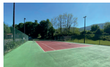
Réfection du cours de tennis
